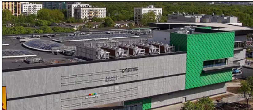
Рисунок 3 – Драйкулеры на кровле ТРЦ в жилом квартале с видом на жилую многоэтажную застройку (фото с балкона соседнего дома)
