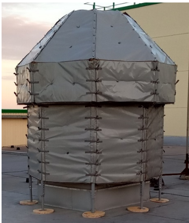
Рисунок 5 – Кожух для снижения шума вытяжной системы
